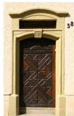
Nageltür 1700–1800 38, rue de Mersch
