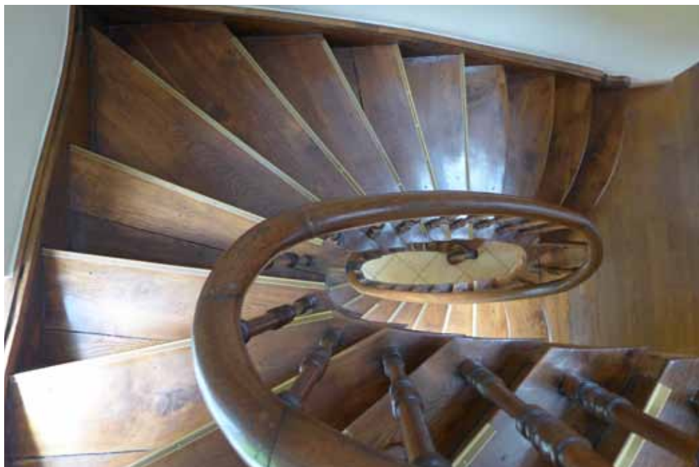
(9) Gekrümmte Holztreppe mit ovalem Treppenauge
