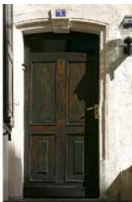
Rahmentür mit Füllung 1830-1890 5, rue Michel Rodange
