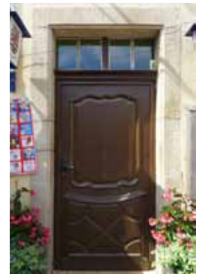
Tür des späten Barock 1780-1820 5, rue de Mersch
