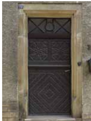
Nageltür 1700–1800 32, rue de Mersch
