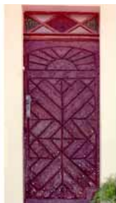
Nageltür 1700–1800 11, rue de Mersch
