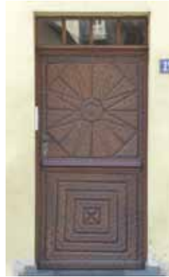
Nageltür 1700–1800 29, rue de Mersch
